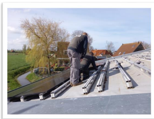
Zonnepanelen tijdelijk verwijderd om liquid rubber aan te brengen op railwerk....
