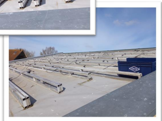
Zonnepanelen tijdelijk verwijderd om liquid rubber aan te brengen op railwerk....
