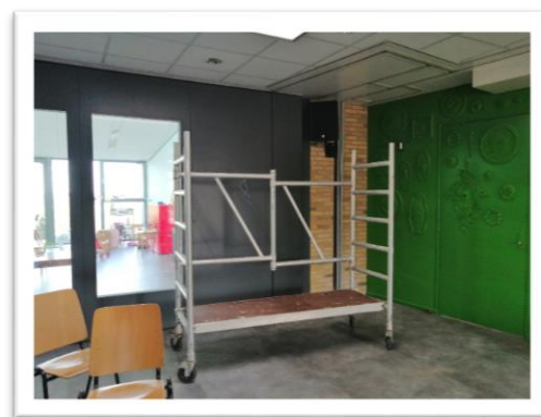
De rolsteiger is al in stelling gebracht voor het aanbrengen van de nieuwe verlichting...
