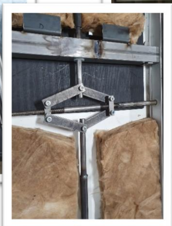
Paneel ingekort, frame gelast en alle onderdelen weer op de juiste plek...
