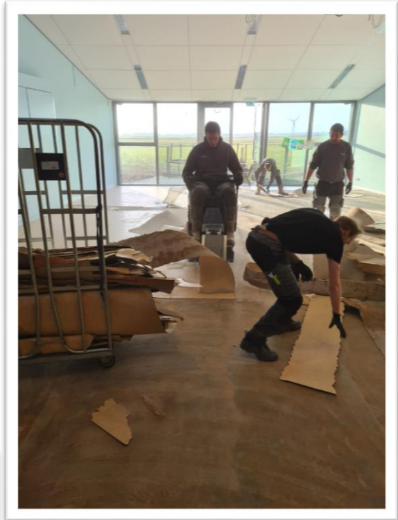
Het verwijderen van de marmoleum vloer met een speciale stripmachine...
