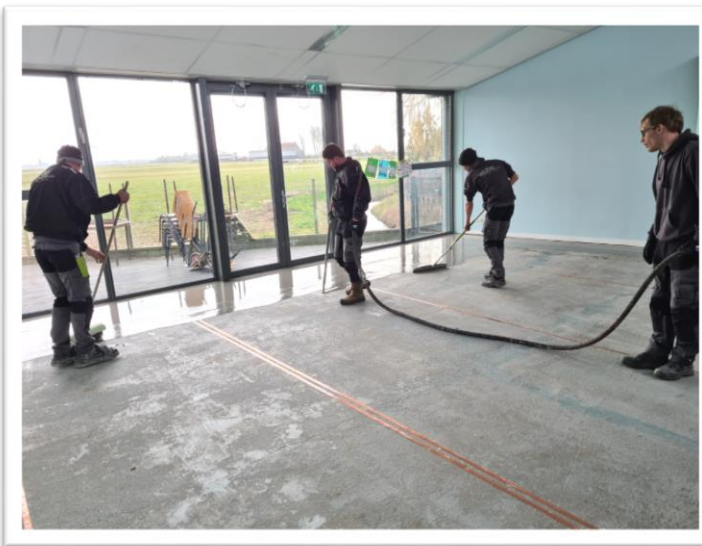
Het aanbrengen van de egalisatievloer; de ringleiding gaat kopje onder...
