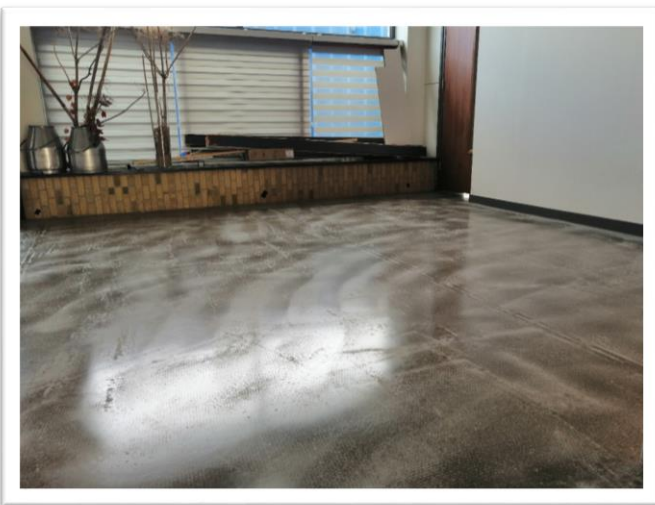
De geëgaliseerde vloer opgeschuurd...
