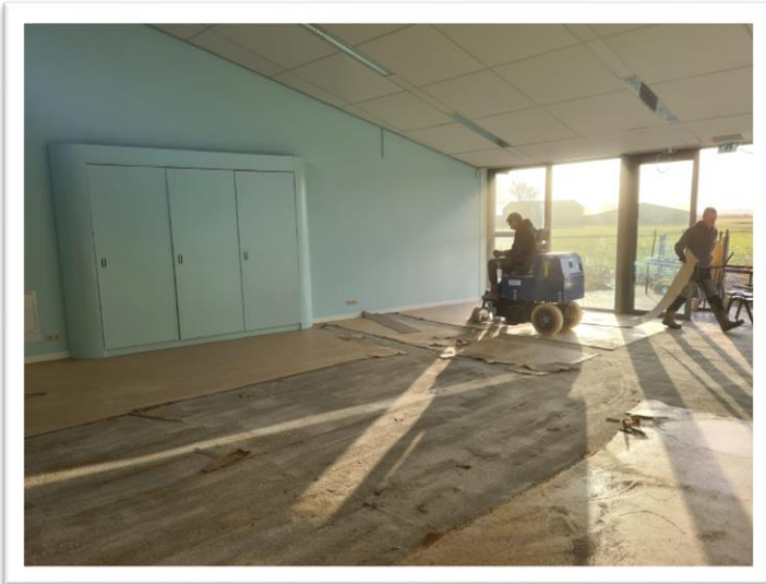
Het verwijderen van de marmoleum vloer met een speciale stripmachine...
