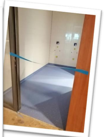
De voorbereidende laag van de Epoxy gietvloer – v.l.n.r. berging –doorgang berging/keuken en keuken...
