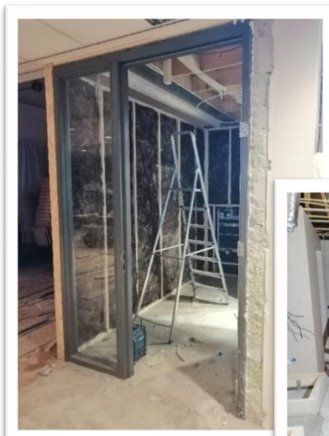
De ingang van de heren wc...
