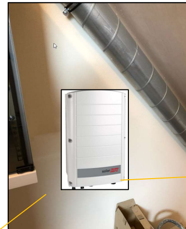
Omvormer op zolder boven warmtepomp
